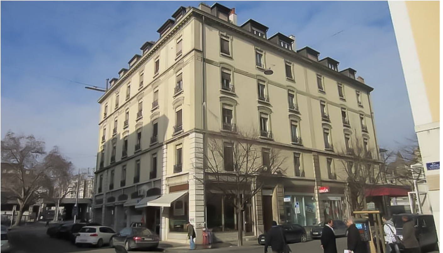
Photographie avant travaux de la façade
